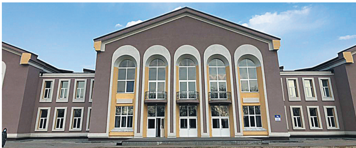
СДК в селе Августовка. В 2020 году произведен капитальный ремонт здания в рамках реализации нацпроекта «Культура»
